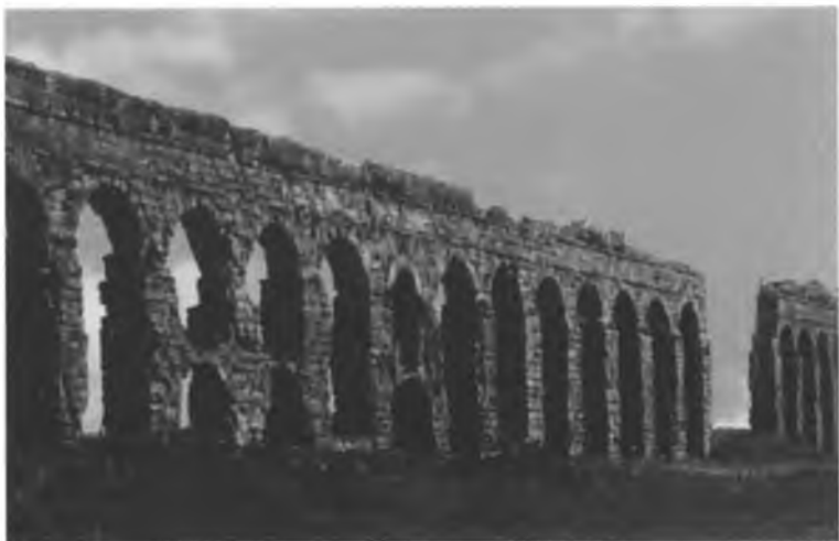
Водопровод Клавдия в Риме.
