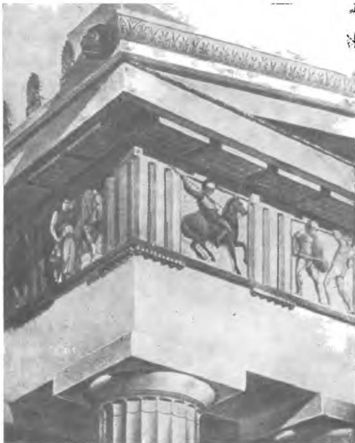
Угол Парфенона с дорическим фризом (реконструкция)
